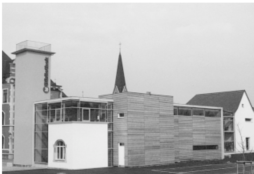
Nach Süden zu hatte das Gebäude in Pieschen ursprünglich kaum Fenster.
